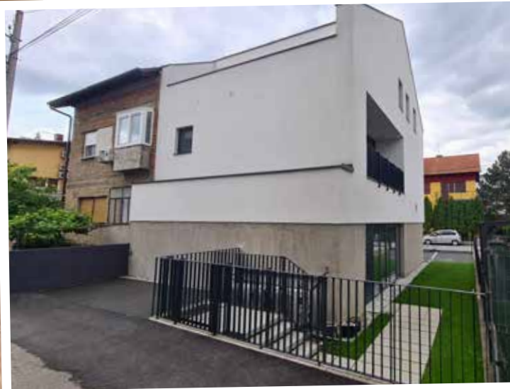
Stražnja strana zgrade
